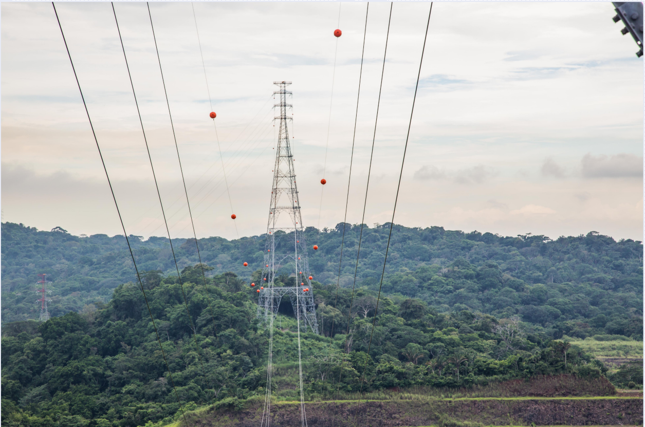
Torres singulares para cruce del Canal de Panamá (160 m de altura)
