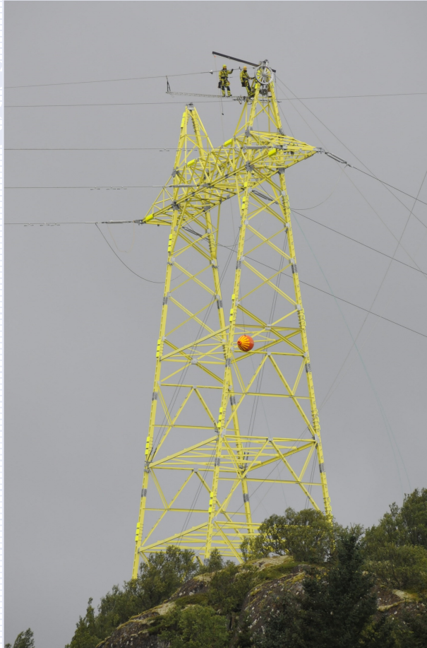
Estructuras singulares para cruce de fiordos diseñadas para montaje con helicóptero.
