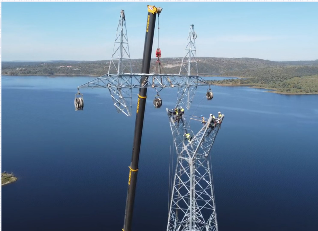
Montaje de torre singular para cruzamiento del río Tajo.
